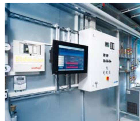
Das umfassende Monitoring-System visualisiert u. a. sämtliche Energieströme.
