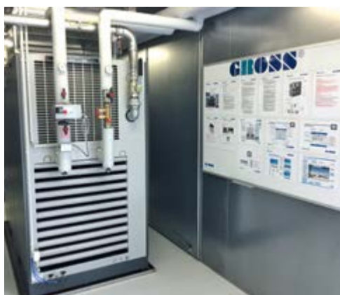
Die Druckluftanlage eines Kundenprojektes mit Wärmerückgewinnung.
