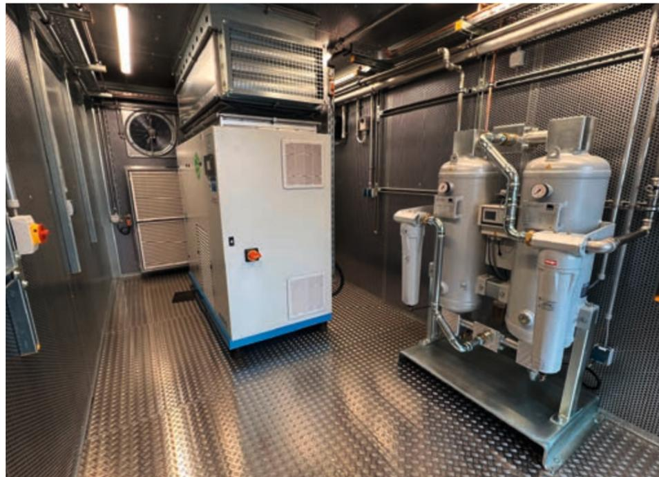
zu beeinträchtigen. Herzstück der neuen Lösung ist ein ölfreier Schraubenkompressor mit einer Leistung von 30 kW vom Hersteller Almig. Ergänzt wird die Anlage durch eine Druckluftaufbereitung mit Komponenten des Aufbereitungsspezialisten KSI, die eine konstant hohe Luftqualität sicherstellen
